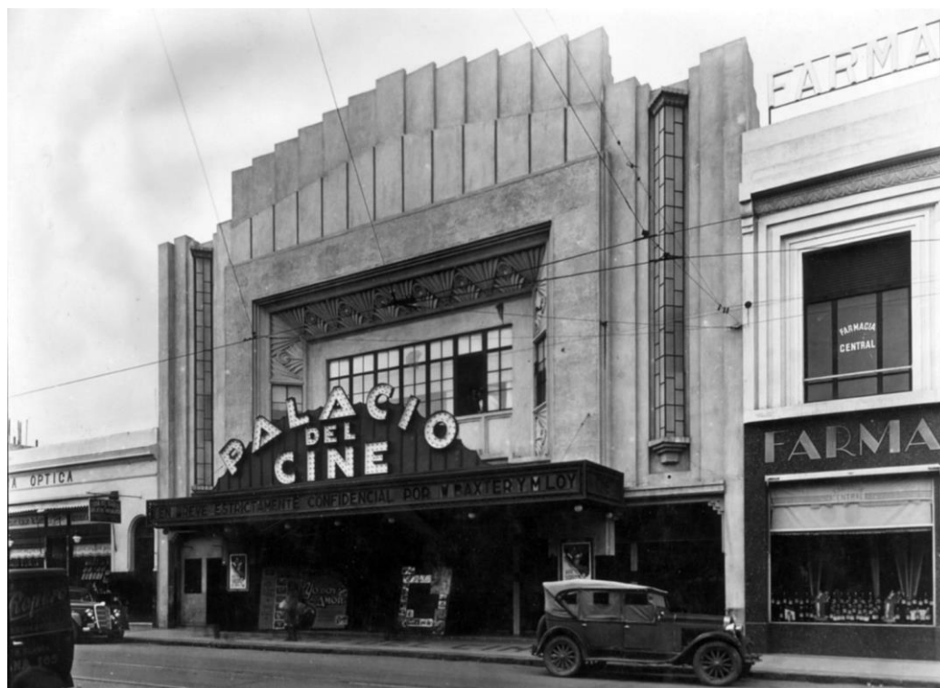
Fachada inaugura en 1932, en Mario Minervino, “Ex Palacio del Cine: el penoso presente de una fachada art déco”, La Nueva Provincia , Bahía Blanca, 11 de marzo del 2018. https://www.lanueva.com/nota/2018-3-11-9-0-0-ex-palacio-del-cine-el-penoso-presente-de-una-fachada-art-deco Visto el 4/3/2020.
