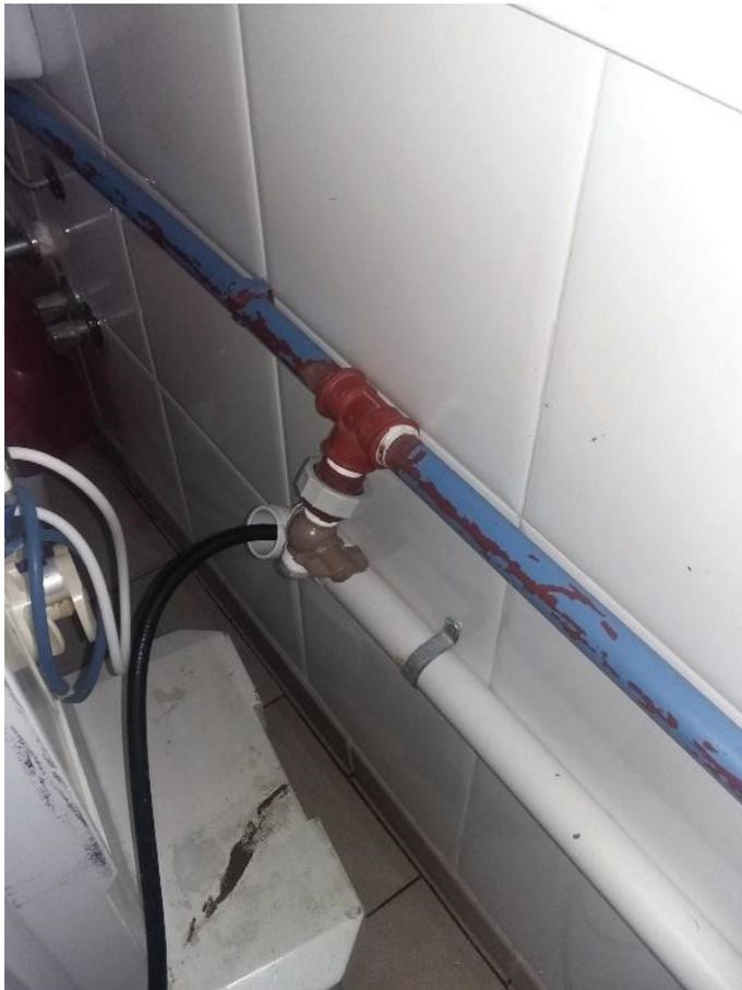
Figura 3-3: Material del anillo de distribución de agua de diálisis (original), no apto para este uso.
