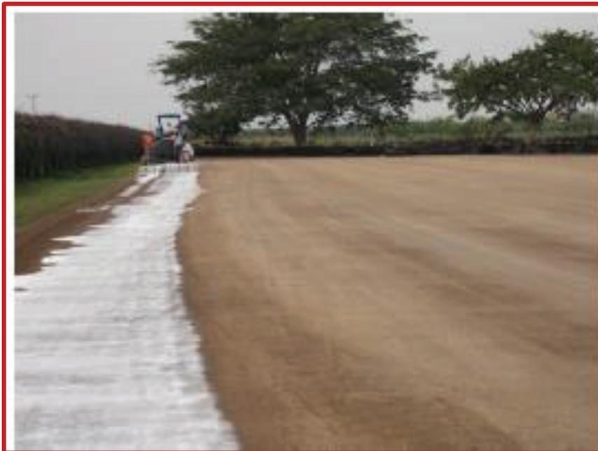
Figura 5-XX. Colocación del aditivo para compactación
