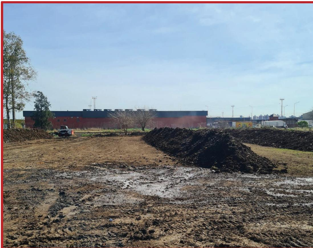
Figura 2-XXXIII Lixiviados acumulados sobre la superficie del predio de Compostaje. Fuente: Propia (2022)
