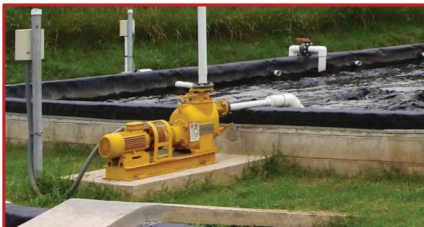
Figura 5-XLII Bomba para extracción de lodos de laguna. Fuente: Aqualimpia
