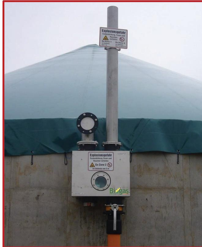
Figura 5-XXXIX Válvula sobre presión. Fuente: Upbiogas
