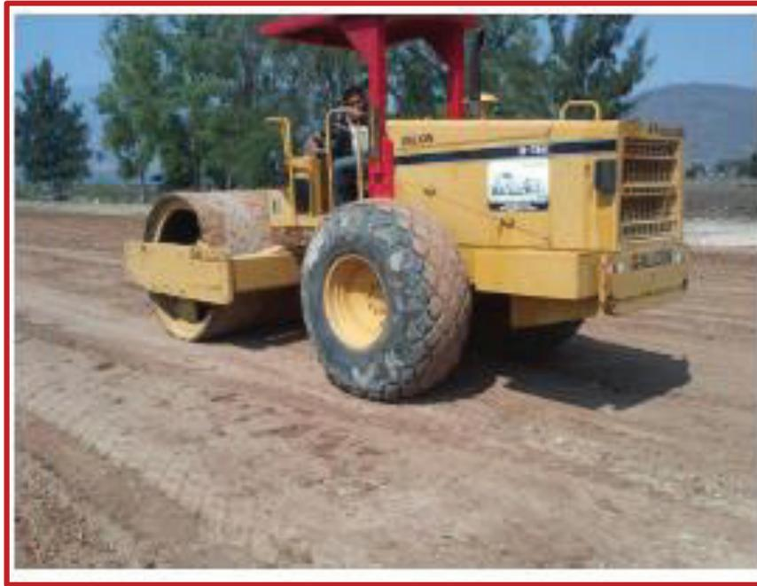
Figura 5-XIX Ejemplo de compactación mecánica del suelo. Fuente
