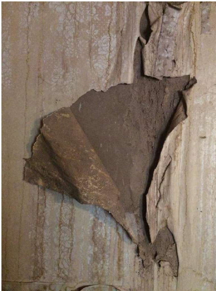
Pared de adobe empapelada en el antiguo comedor de la Familia Boric. Registro de campo de la autora (Tinogasta, 2016).
