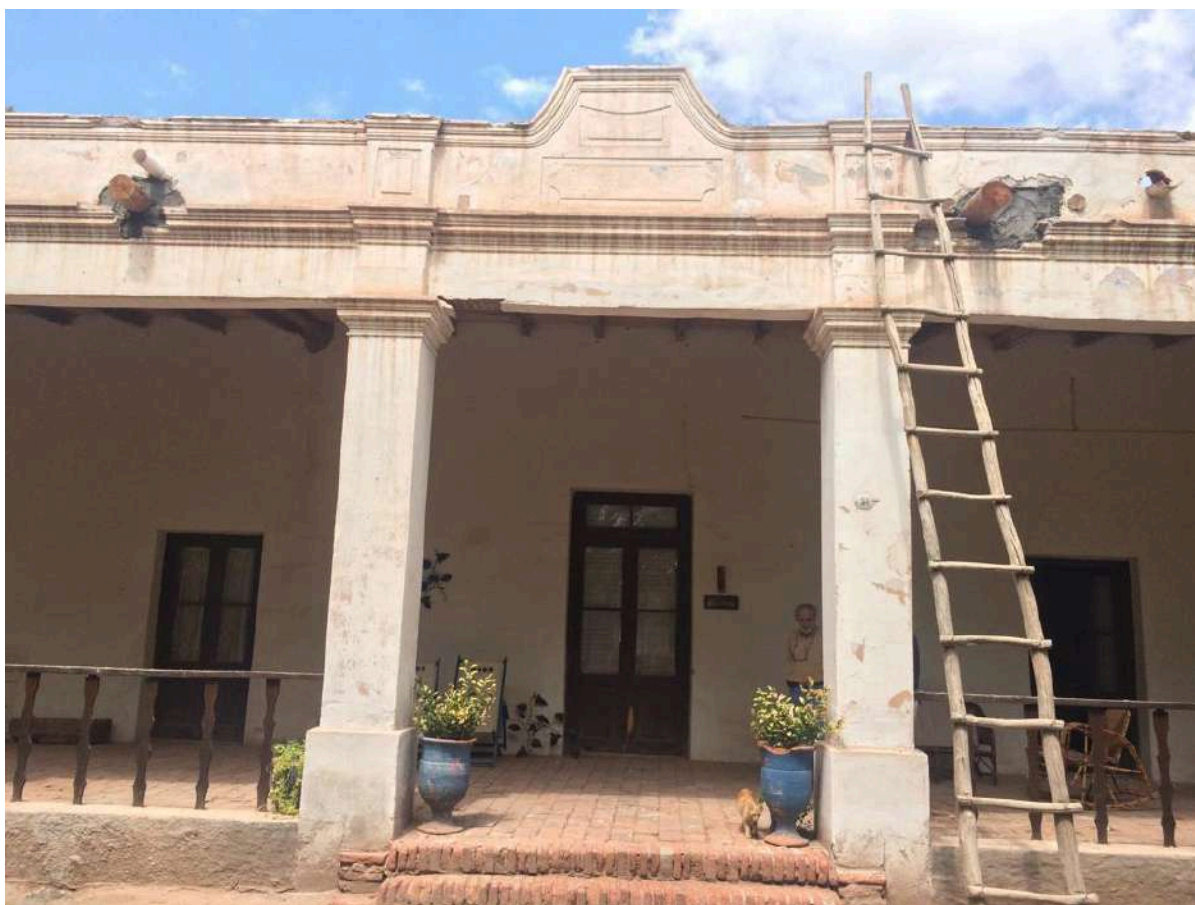
Fachada de la casa de los boric en proceso de restauración. Registro fotográfico de la autora (Tinogasta, 2019).
