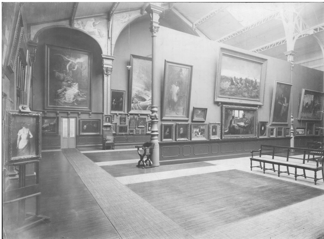
A la derecha, la Sala de Arte Argentino del Pabellón Argentino. Se pueden ver dos obras de Ballerini, Coro de la iglesia de dei Frari (Venecia), y La Cascada del Iguazú , 29 de julio de 1911. Archivo General de la Nación. Departamento de Documentos Fotográficos, 169073
