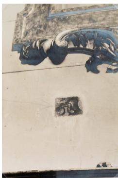
Figura 6. Teste de remoção de repintura, descoberta de pintura subjacente após remoção de 4 camadas de tinta a óleo durante restauração em 1970 – painéis parietais da capela-mor da Igreja de Nossa Senhora do Pilar. Fonte: ACI - Série Centro de Restauração de Bens Culturais.
