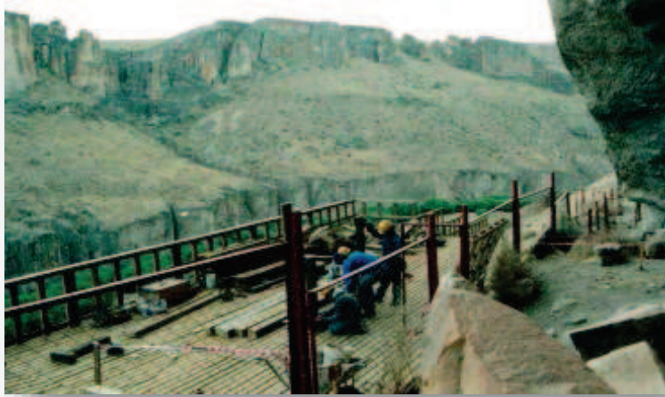
Fotografía 22. Construcción de decks
