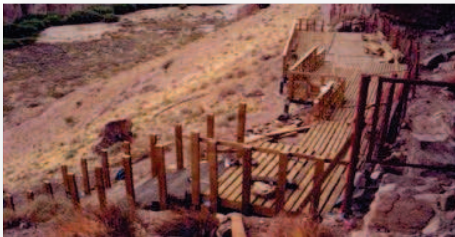
Fotografía 21. Construcción de pasarelas
