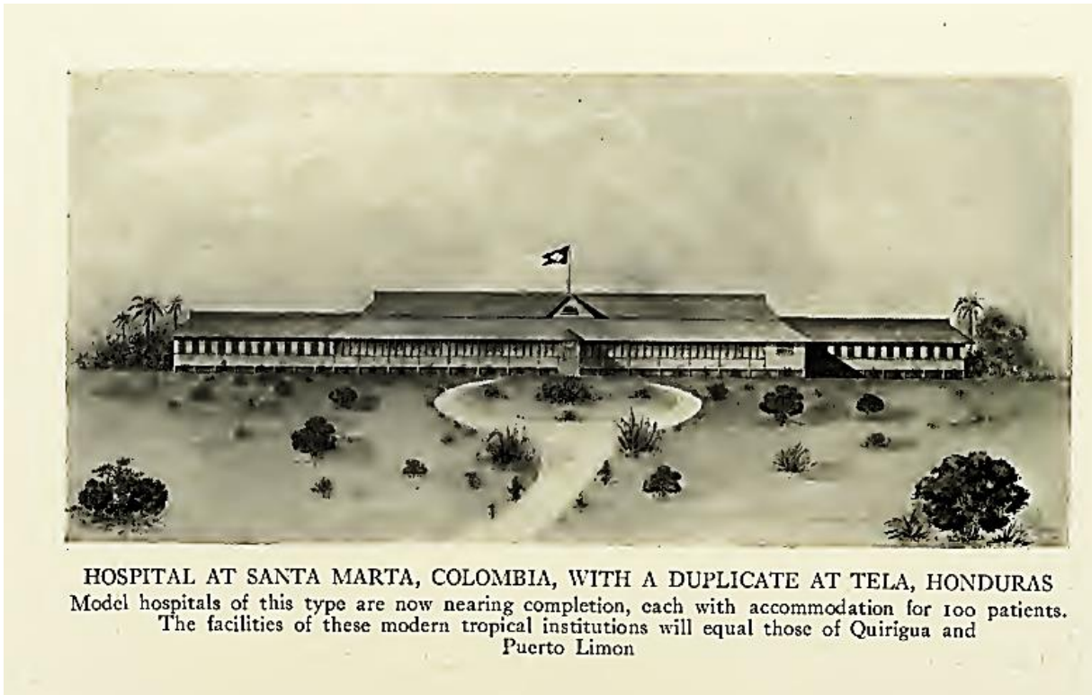
Figura 5. Hospital de la UFCO en Santa Marta, Colombia hacia 1910 aproximadamente 61 .
