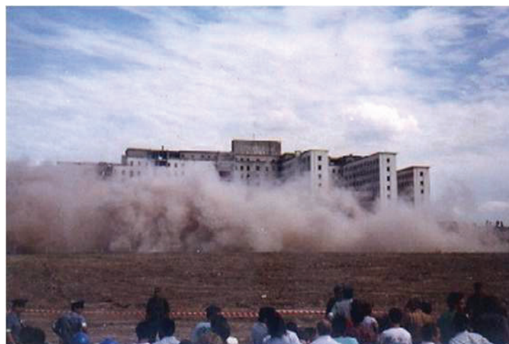
Figura 13. Otro aspecto de la demolición del Albergue Warnes.
