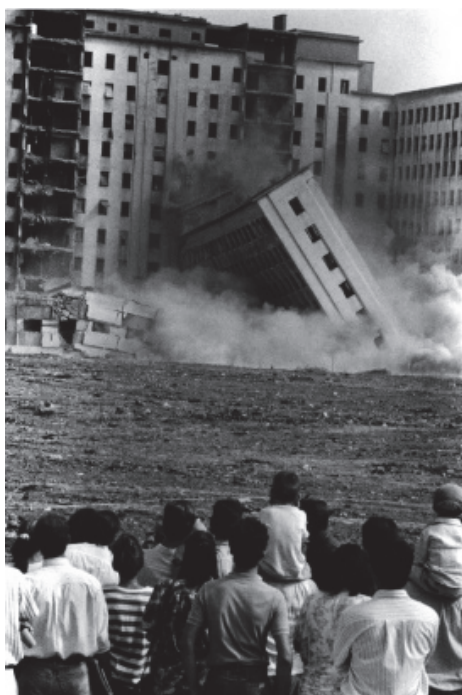
Figura 12. Un aspecto del proceso de demolición del albergue Warnes.
