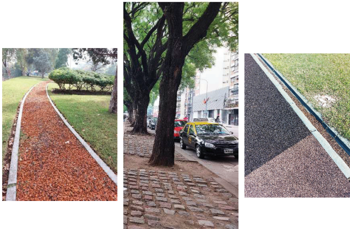
Figura 64. Diferentes tipos de pavimento permeable: en Parque Los Andes, sendero de ladrillo partido (izquierda) y adoquines entrelazados sobre la acera de la Av. Corrientes (centro); concreto permeable en el sector de juegos infantiles en “La Isla de la Paternal”, (derecha).
