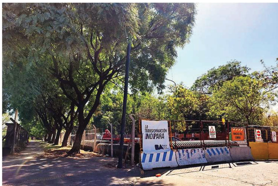
Figura 24. Vista del obrador instalado sobre la Av. de los Constituyentes.
