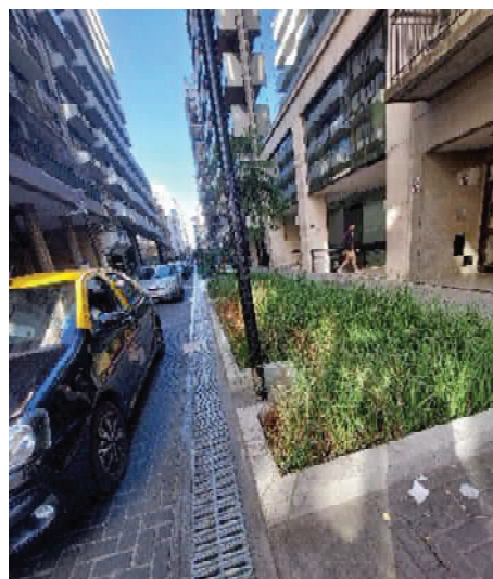
Figura 63. Zanja con vegetación en calle Esmeralda al 1000, CABA.
