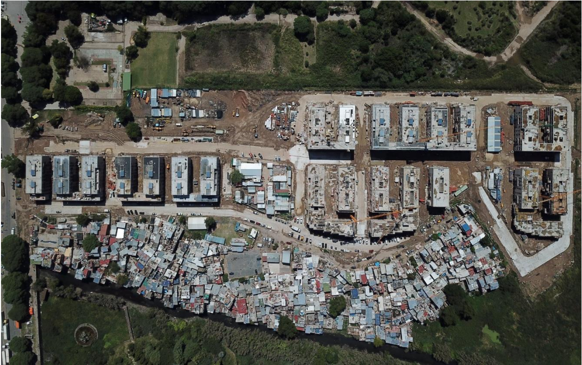
Imagen 5. Vista aérea de avances de obra de vivienda nueva y macizo.
