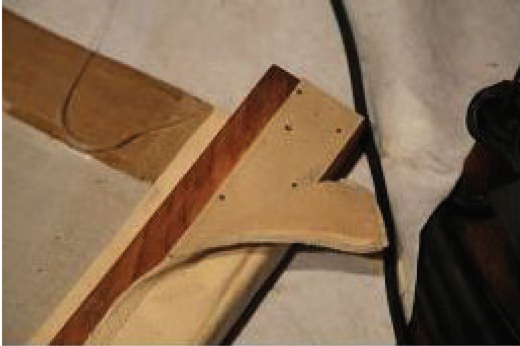
Figura 79: Reemplazo del sistema de anclaje al cabezal superior.
