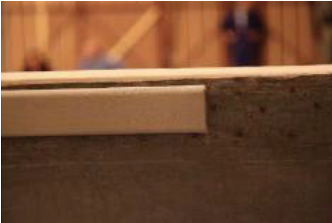
Figura 81: Terminación de la sujeción del telón.
