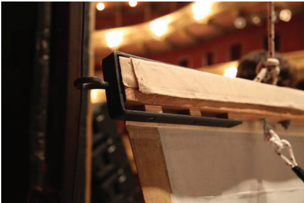
Figura 80: Nuevo sistema de amarre de las drizas al cabezal superior.
