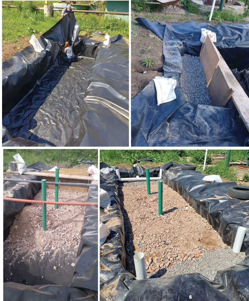
Figura V.13. Proceso de colocación de los distintos sustratos y del sistema de aireación, ingreso y egreso del efluente.
