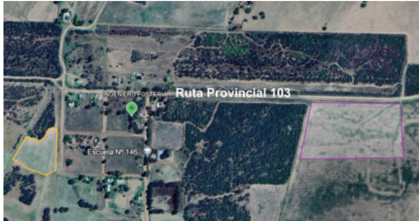
Figura IX.6. Predios destinados a la planta potabilizadora de agua (en naranja) y a la planta de tratamiento de efluentes cloacales (en violeta) en la localidad de Ingeniero Foster.
