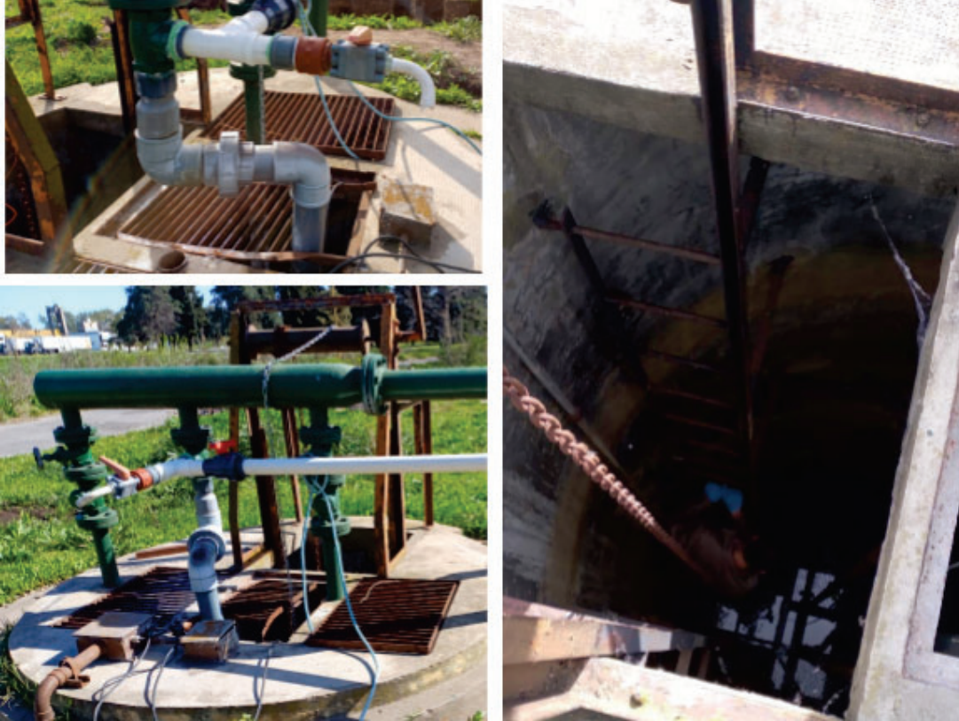
Figura V.19. Sitio de muestreo del efluente cloacal del INA. Se muestra la profundidad del pozo y la canilla dispuesta para la toma de muestras.
