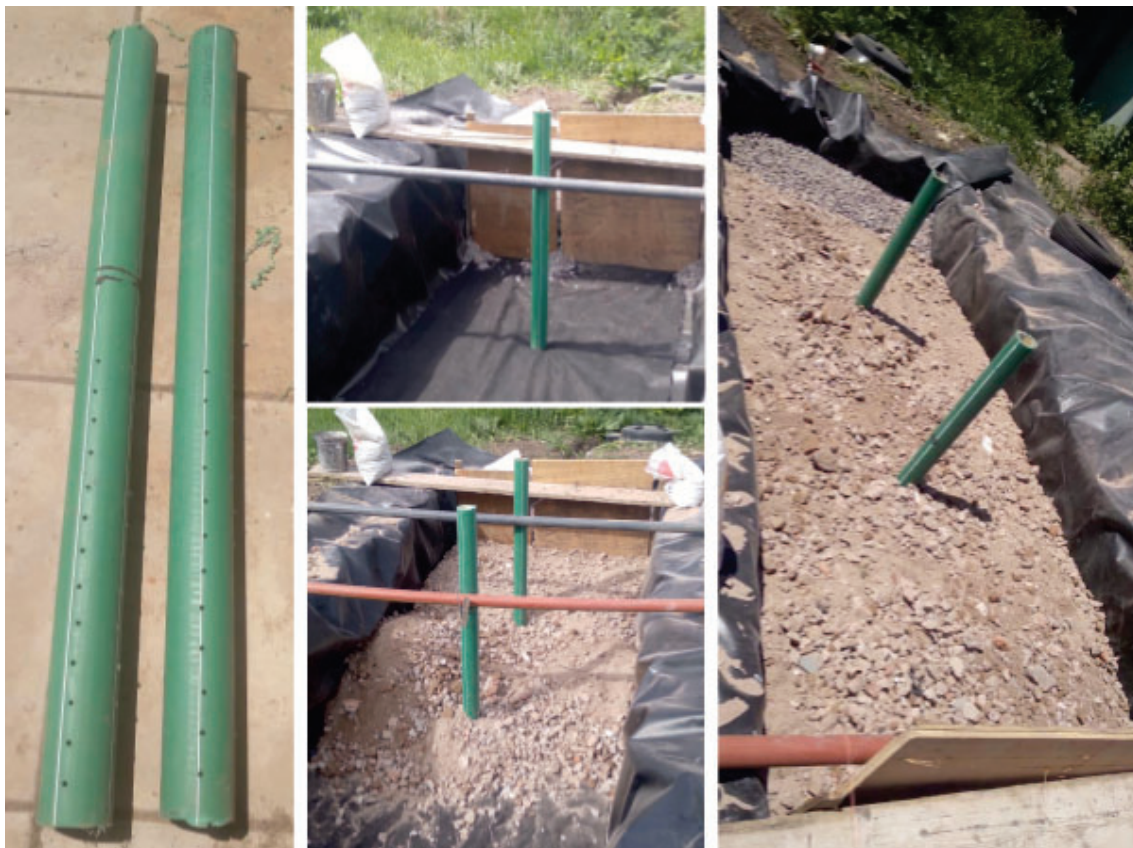
Figura V.9. Sistema de aireación pasiva colocado en el HAHFSS.
