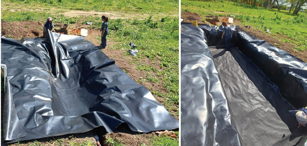
Figura 9. Proceso de colocación de la geomembrana de impermeabilización en un humedal domiciliario.
