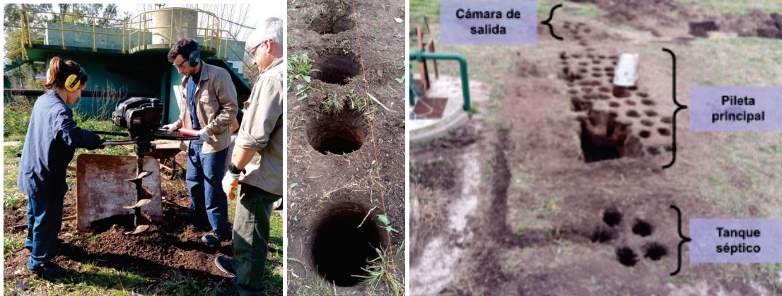
Figura V.11. Perforaciones para la construcción del humedal piloto.
