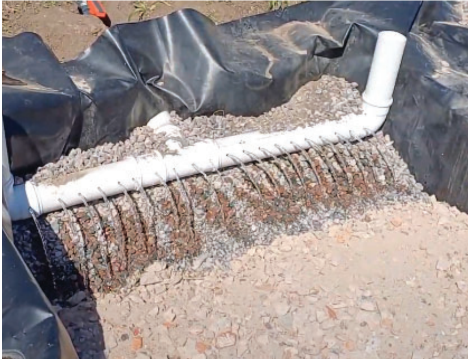
Figura 10. Sección de entrada. Se realizó una prueba para garantizar que el flujo se distribuya uniformemente y que la cañería no presente obstrucciones por residuos plásticos.
