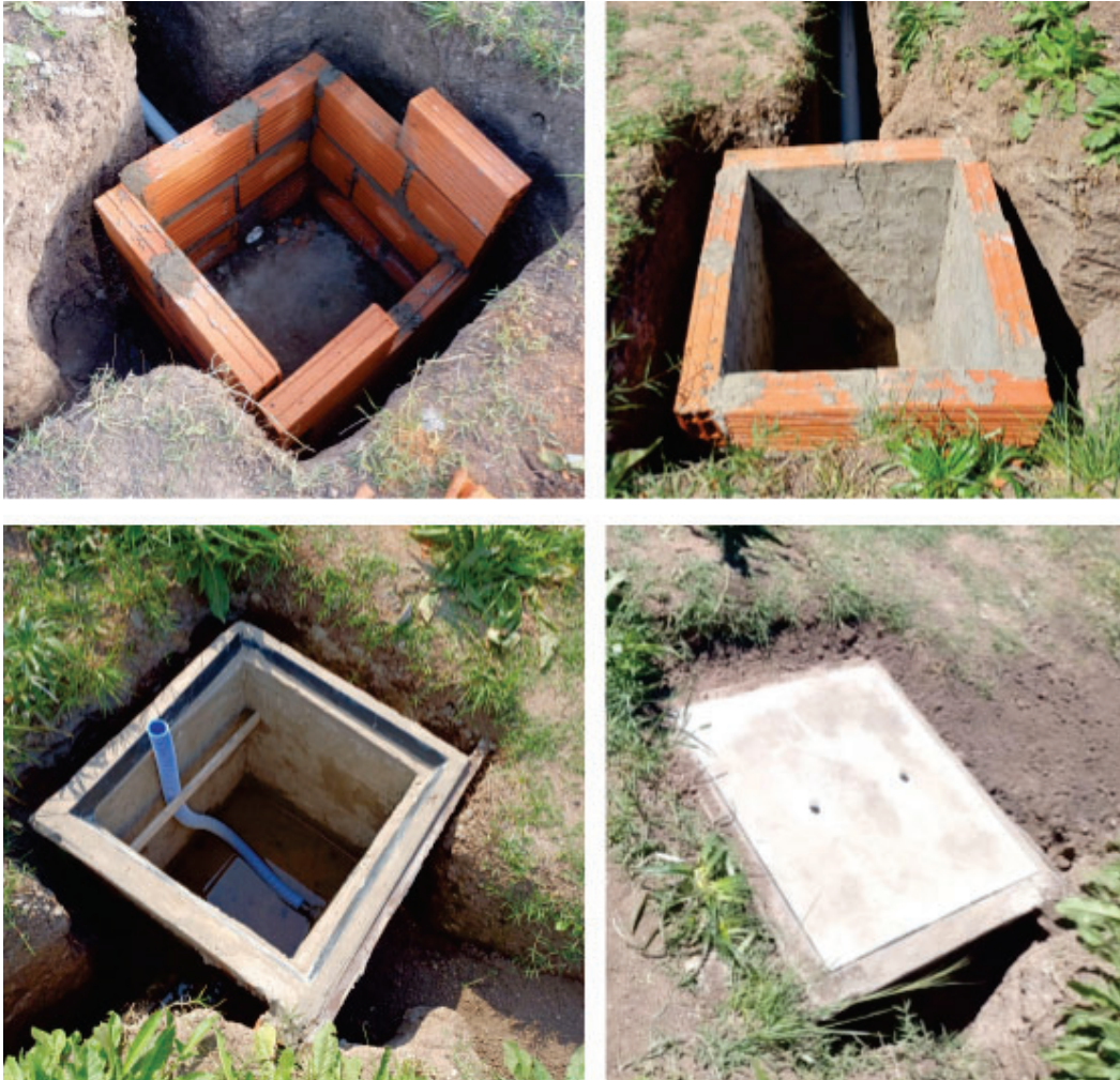
Figura 11. Armado de la cámara niveladora de un HAHFSS doméstico.
