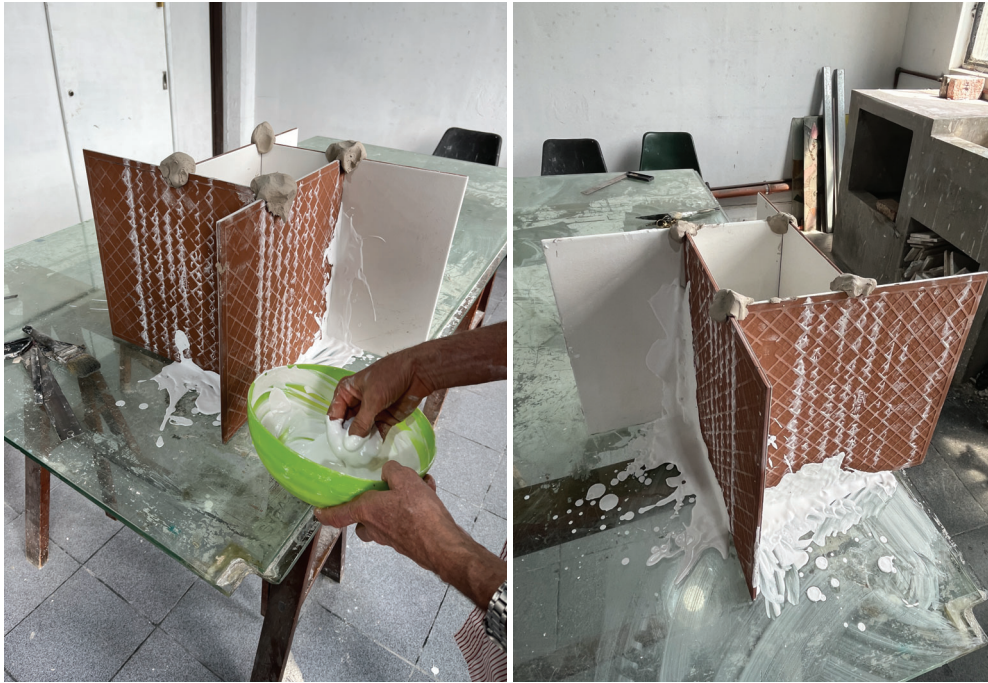
Imágenes 48 y 49- Sellado del encofrado con yeso denso
