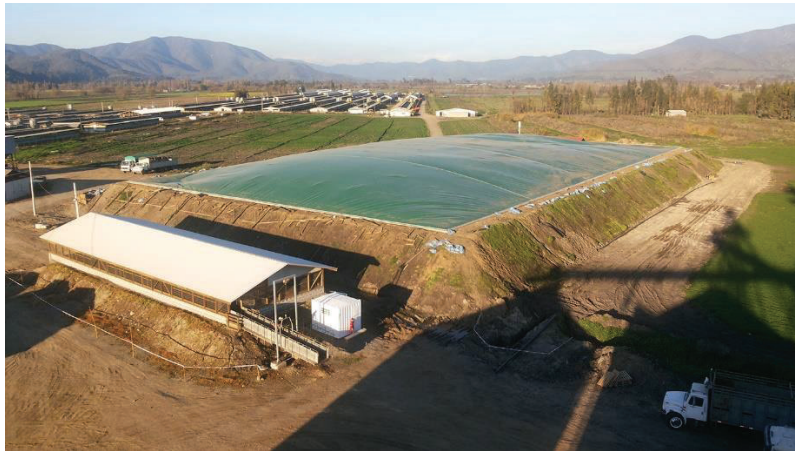
Figura 17 : Laguna anaeróbica cubierta. Fuente: Google imágenes.
