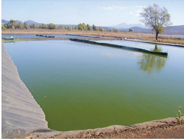
Figura 18 : Laguna facultativa. Fuente: Google imágenes.
