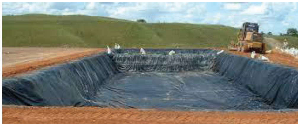
Figura 30 : Geomembrana impermeabilizando el terreno de la laguna.
