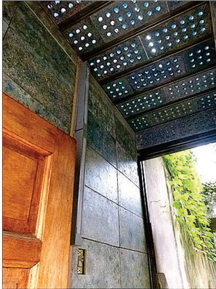
Figura 11. Estudio de Caso sobre aplicación de placas de papel cemento en paredes y cielorraso en una vivienda en CABA 51
