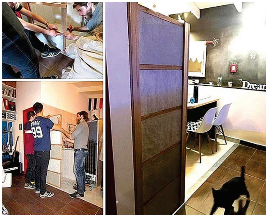
Figura 19. Montaje del panel separador con placas de papel cemento 62
