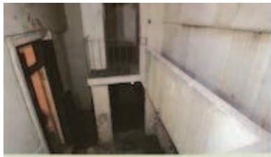
Es el espacio se realizan tareas de preservación de las instalaciones donde funcionó el CCO.
