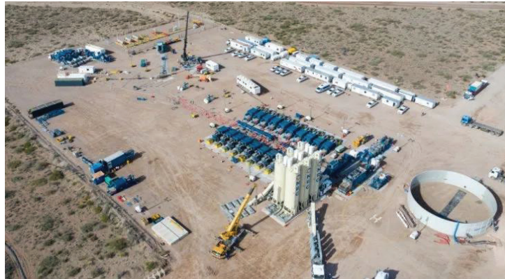
Figura 2.14: Set de fractura de Tenaris, trabajando en locación.
