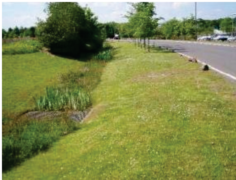
Imagen N° 30. Fotografía de franja filtrante. Fuente: Perales Momparler (2019).
