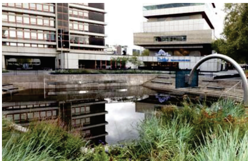
Imagen N° 47. Ejemplo de balsa de detención - en período de lluvia. Fuente: Perales Momparler (2019).
