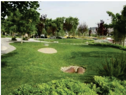
Imagen N° 19. Ejemplo de balsa de infiltración. Fuente: Perales Momparler (2019).
