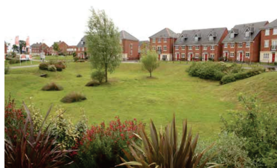
Imagen N° 48. Ejemplo de balsa de detención seca - entre períodos de lluvia. Fuente: Woods Ballard et al. (2015).
