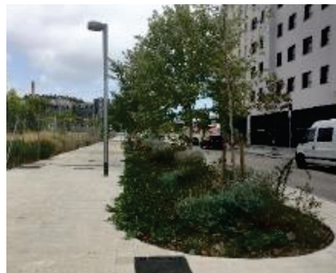
Imagen N° 37. Fotografía de dren filtrante. Fuente: Fegan & Schwerdtfeger (2022).
