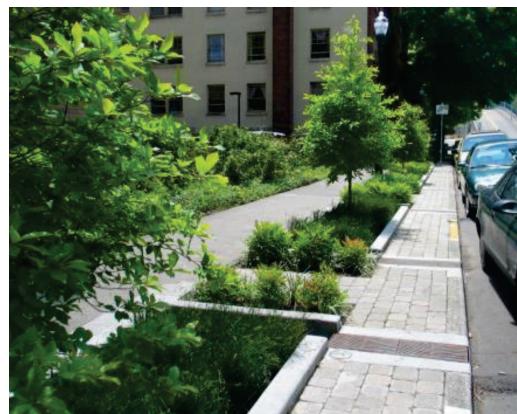
Imagen N° 40. Fotografía de un sistema de biorretención. Fuente: Fegan & Schwerdtfeger (2022).
