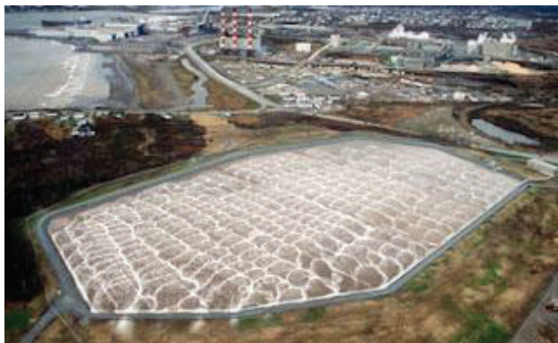
Figura 47: Laguna aireada. Fuente: (Osorio, 2013)
