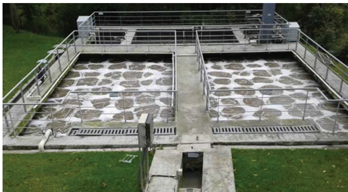
Figura 49: Reactor de lodos activos operando. Fuente: (Junco, 2015)
