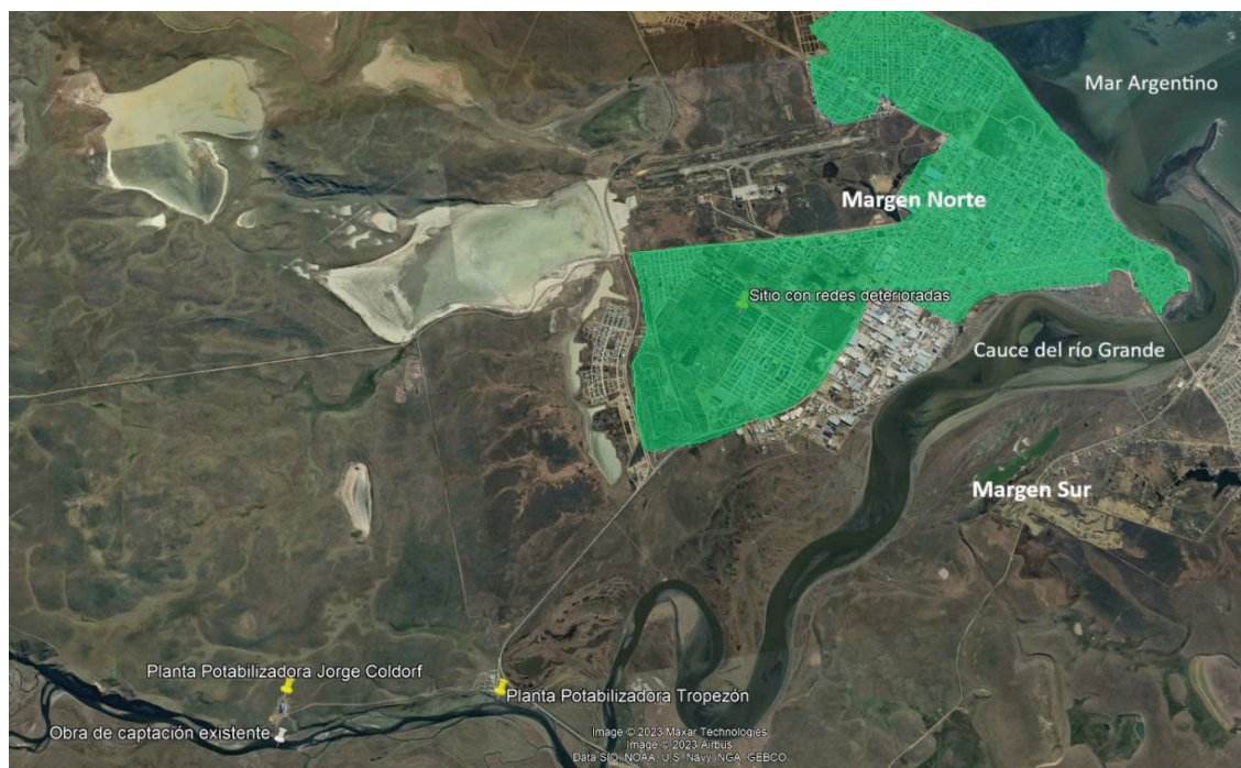
Figura 4: Infraestructura existente: obra de captación, planta y sitio del ejido de urbano con redes deterioradas. Elaborado con Google Earth.
