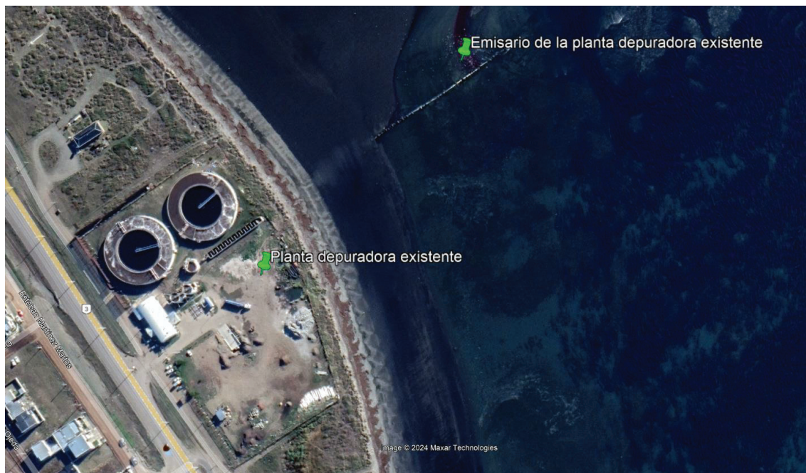
Figura 5: Planta depuradora de efluentes cloacales existente en Margen Norte y emisario. Elaborado con Google Earth.
