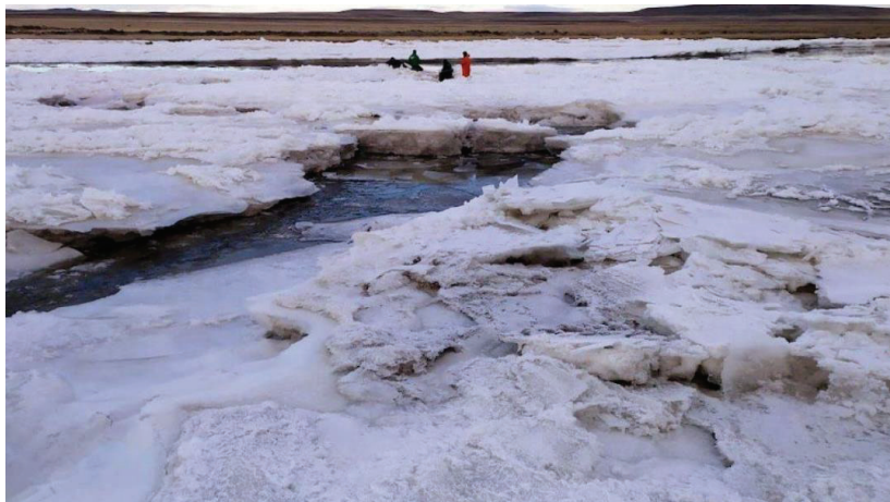
Figura 33: Cuadrilla haciendo trabajos de desobstrucción de la toma debido al hielo acumulado en las capas superiores del río. Fuente: (Sur54, 2021)
