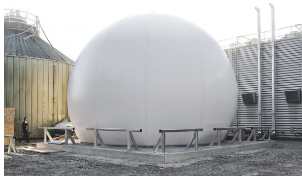
Figura 7.4. Gasómetro Aqualimpia
