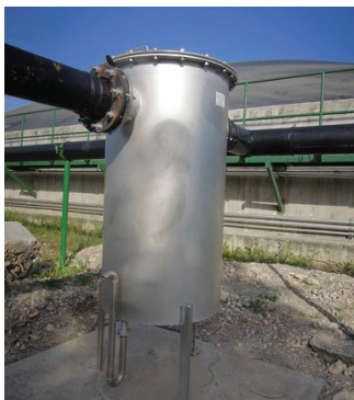
Figura 7.6. Trampa de humedad.
