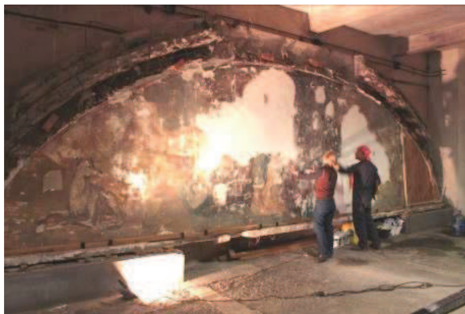
Fig. 21. Otoño luego del incendio
