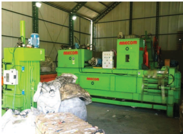
Figura 14.12: Prensas enfardadoras vertical ((izquierda) y horizontal (derecha) de la planta de clasificación de residuos de Aluminé. Fuente: Producción propia.
