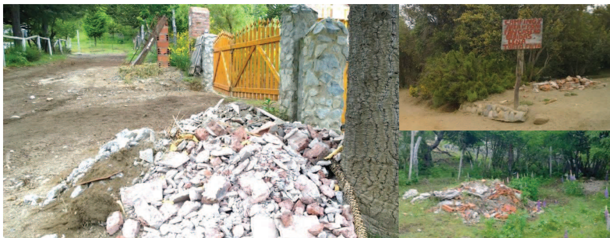
Figura 2.27: Fotografías de montículos de residuos áridos en la vía pública, en el municipio de Villa Pehuenia-Moquehue. Fuente: Producción propia.
