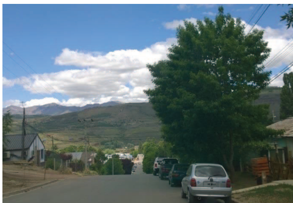
Figura 14.8: Calle pavimentada en Aluminé. Se aprecian las variaciones de altura en la topografía. Fuente: Producción propia.
