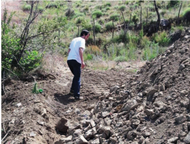
Figura 14.28: Visita y recorrido por las obras que se realizan en el basural a cielo abierto de Aluminé. Fuente: Producción propia.
