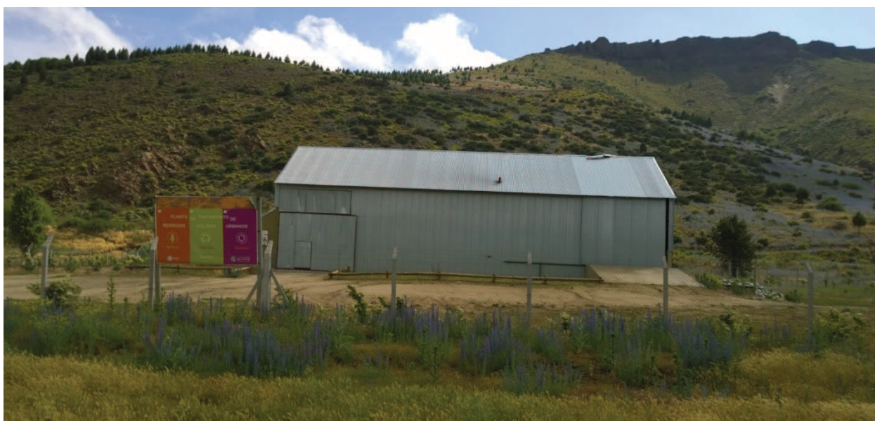
Figura 2.7: Fotografía de la planta de clasificación de residuos de Aluminé, tomada desde la ruta. Fuente: Producción propia.
