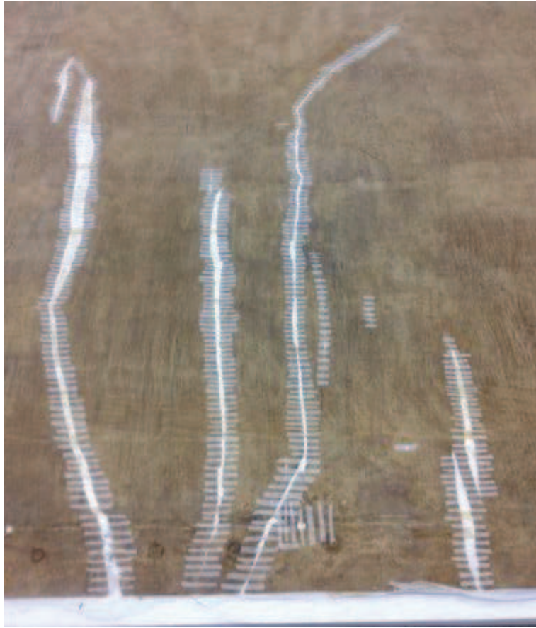
Imagen 35: Sujeción provisoria de roturas y faltantes.
